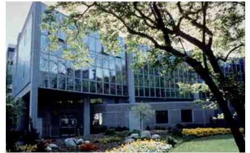
Nouveau bâtiment créé en 1987 pour recevoir les réserves, l'administration et le technique.
